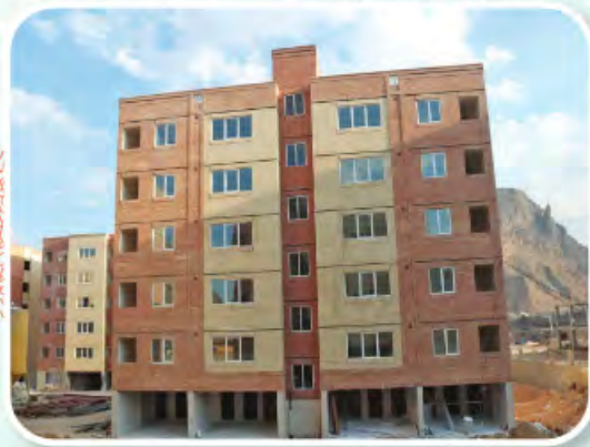
پروژه مسکونی ۱۶۰ واحدی شهر تفت
